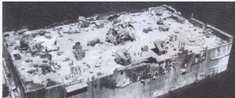
**Самый странный в нашей военно-морской истории корабль, был сконструирован капитаном 1-го ранга Григорием Бутаковым. Это была несамоходная плавучая стальная «баржа» прямоугольной формы, с пушками и зенитными пулеметами, размером 50 метров в длину, 30 метров в ширину, с высотой борта 15 метров.**
